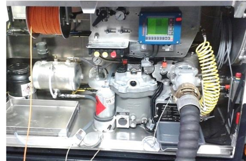
Armaturenschrank auf einem Straßentankwagen
